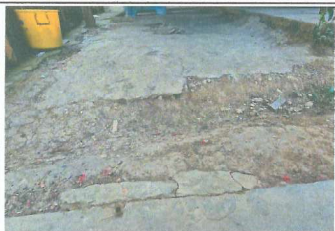
Foto 3: Mejoramiento de losa de piso en la cocina.
