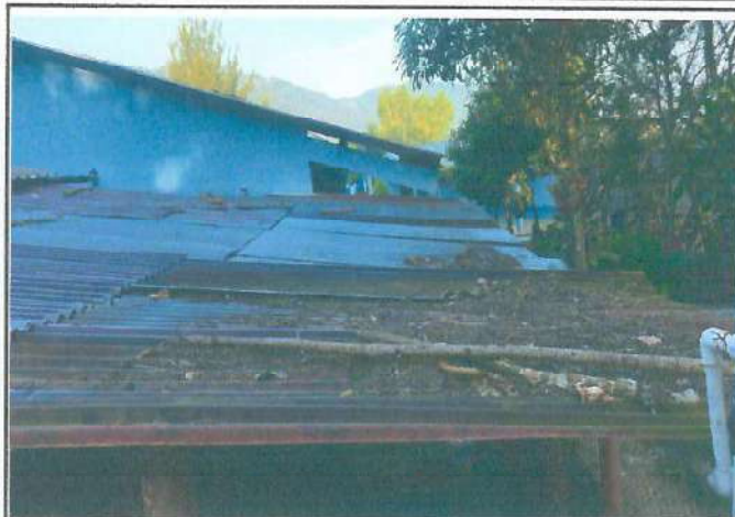
Foto 2: Mejoramiento con estructura tipo pórtico e instalación de lámina troquelada calibre 26 en la cocina
